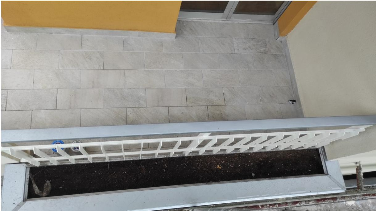
6° piano: balcone ovest – da rifinire la parte bassa in corrispondenza dello scasso per alloggio tubazione e sostituire griglia di areazione cucina.
